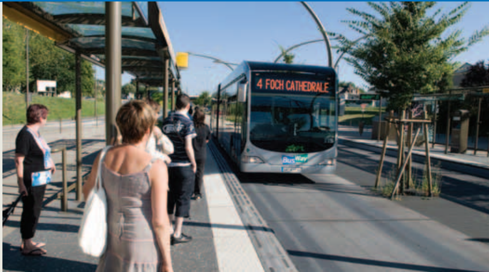
Le Busway à Nantes a remplacé un projet de tram onéreux. (Photo EvoBus)
